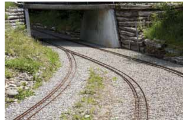
Brücke/Unterführung kurz nach der Ausfahrt aus dem Bahnhof.
